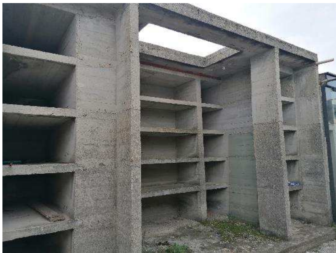
Foto 4: Foto tomba esistente oggetto di intervento con struttura in c.a.
