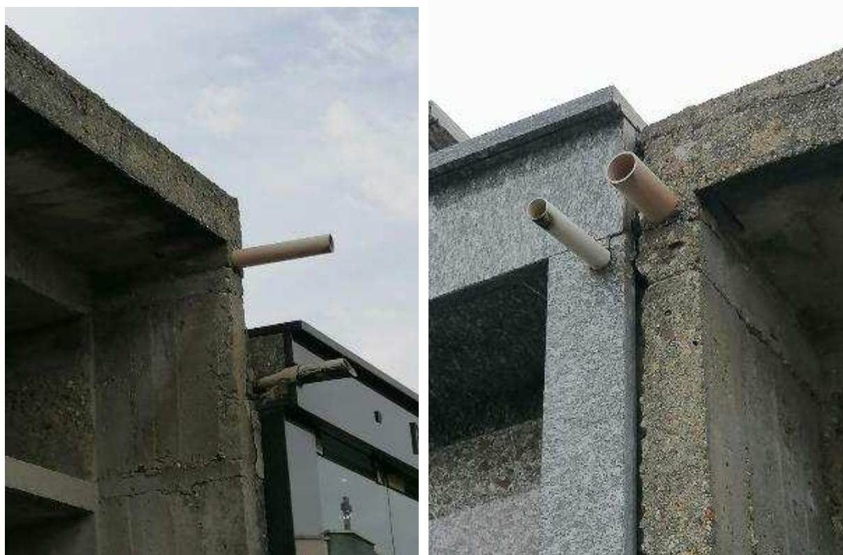
Foto 9-10: Foto dei dettagli degli scarichi delle acque meteoriche della tomba esistente e delle adiacenti (Fam. Franceschi e Bertero)
