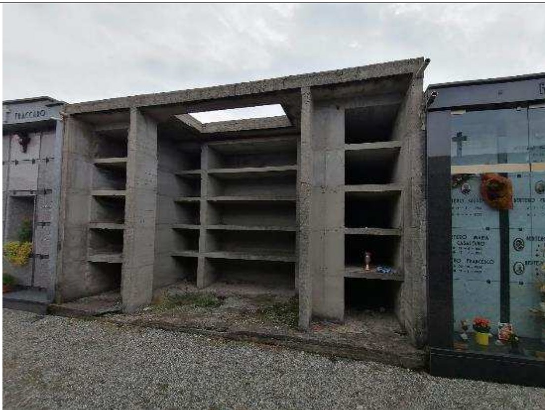
Foto 3: Foto tomba esistente oggetto di intervento con struttura in c.a.
